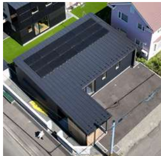
屋根設置の太陽光発電
